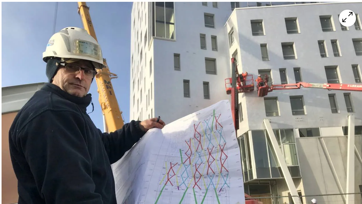
Angers, bd Jean-Moulin, 20 janvier 2021. Soizic Duret, chef de chantier de l'entreprise de gros œuvre, avec le plan de la Tour TIP avec sa résille en béton, à fixer sur les 14 étages et 4 faces de la construction. | CO – ANTHONY PASCO
